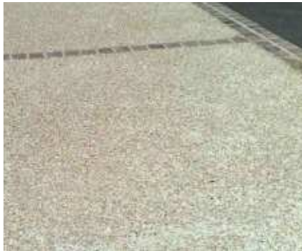
Béton désactivé sur trottoirs
